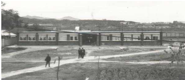
1965-66년경에 힐 요한 선교사가 완공한 본관 건물
