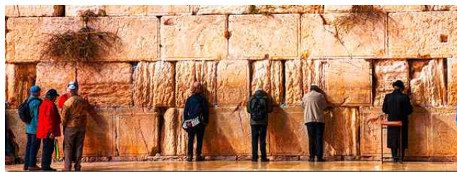
예루살렘 성전의 서쪽 벽(동쪽의 벽) 이 커다란 돌단이 광장 아래로 17단, 광장 위로 7단 더 있다. 여기에 이보다 더 작은 돌들로 주후 600년에 4단, 더욱 작은 돌들로 1866년에 13단, 더더욱 작은 돌들로 1967년에 3단이 덧쌓아졌다.
